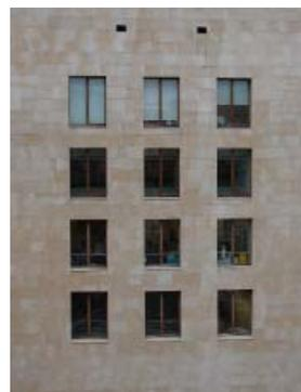
Un nuevo avance en este tipo de fachadas consistió en dejar una cámara de aire entre el aplacado y la estructura que evitaba los problemas producidos por las dilataciones térmicas y por el agua de lluvia. Más tarde, y para mejorar el aislamiento térmico, se coloca un material aislante en la cámara de aire sobre el soporte interior que se apoya en la estructura del edificio.
