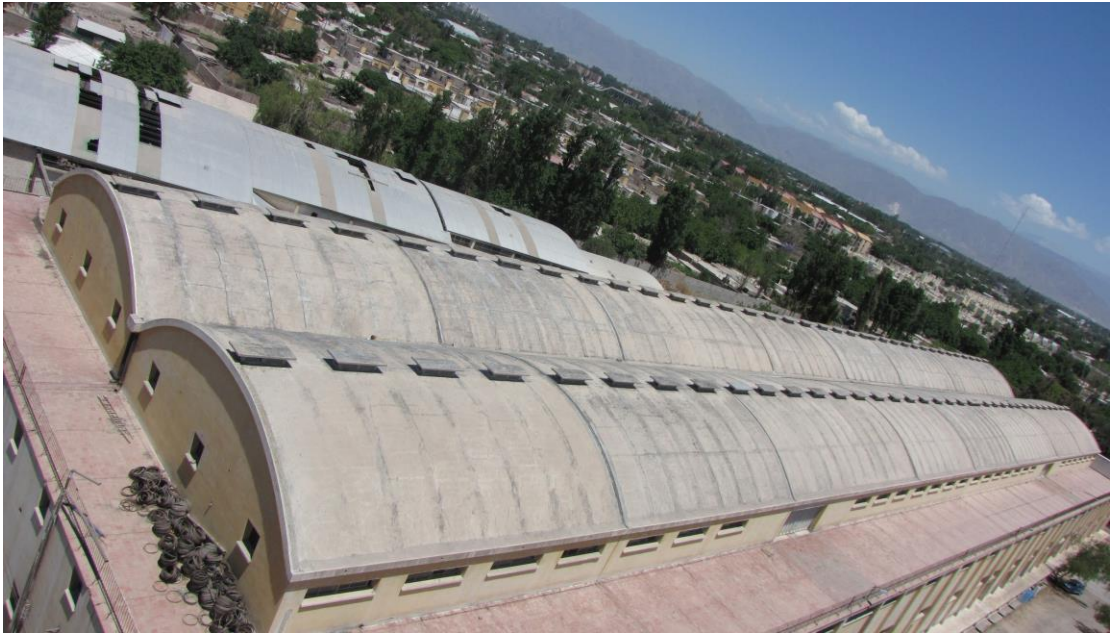
Vista desde el Tanque de Agua. Cuerpo N°3.
