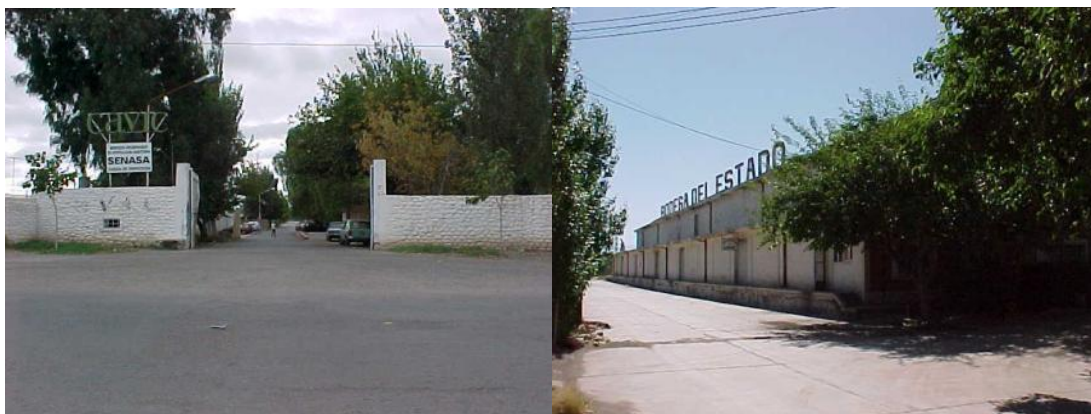
Acceso principal y calle interna.
